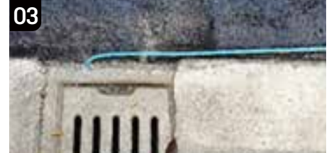
우수받이 구멍 뚫기 및 유공관 설치
