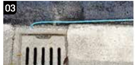
우수 받이 구멍 뚫기 및 유공관 설치
